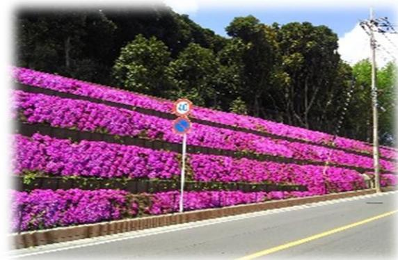
◎クイック・ストッパー工の主材料である鋼製土留柵「土留メッシュ」は、静和建设株式会社と小岩金網株式会社の共同開発品を使用しています。
